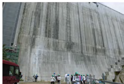
様々な角度からダムの見学をさせていただきました。
